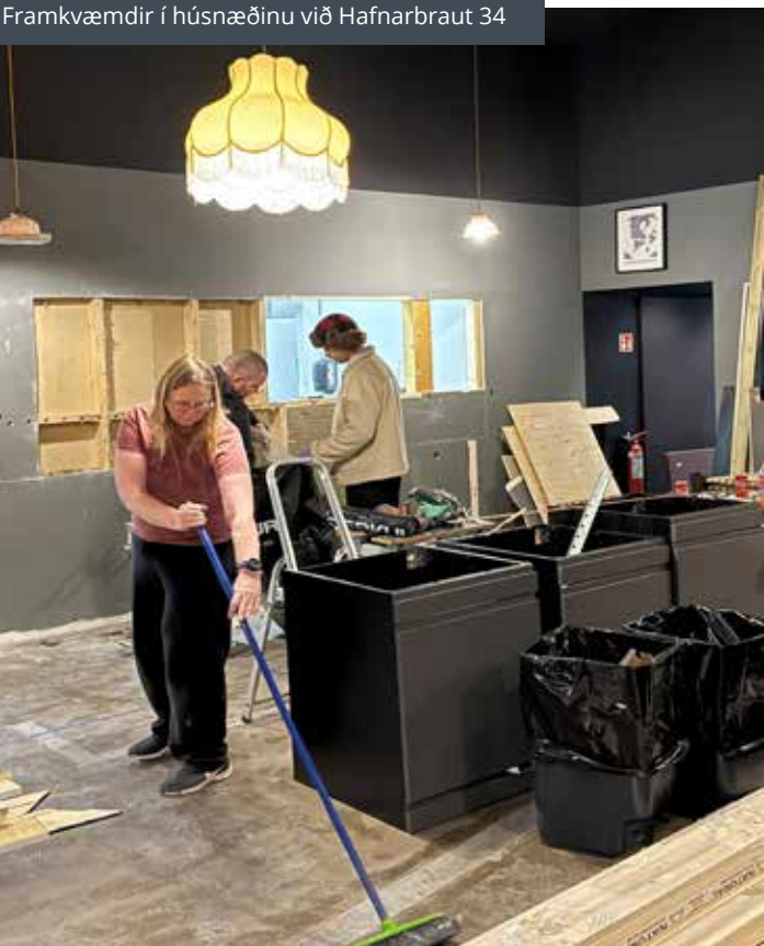
Framkvæmdir í húsnæðinu við Hafnarbraut 34
